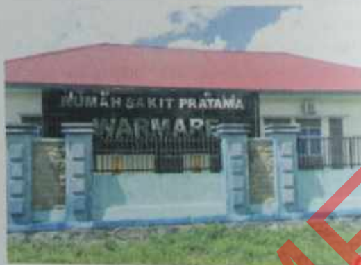
Tahun 2018 dibangun RS Pratama melalui anggaran DAK APBUDAS 2018
