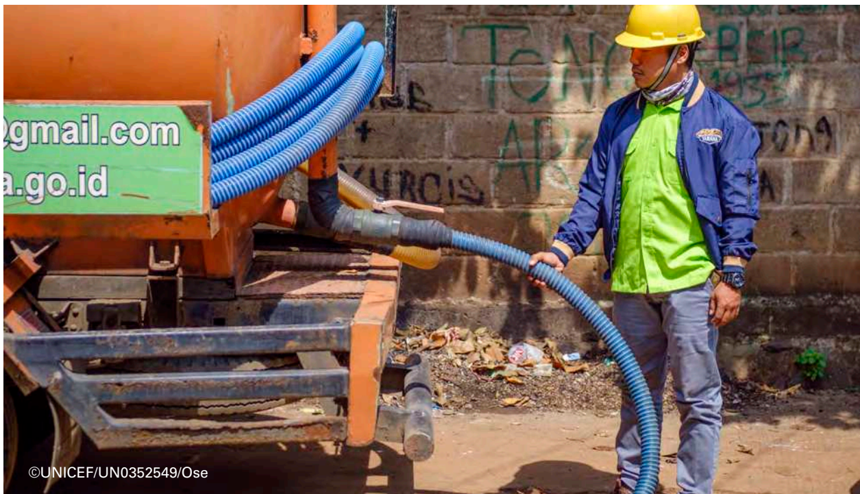
Gambar 6: Menyedot septic tank rumah tangga yang selanjutnya akan diproses di Manajemen Limbah Cair Rumah Tangga di Kota Bekasi
