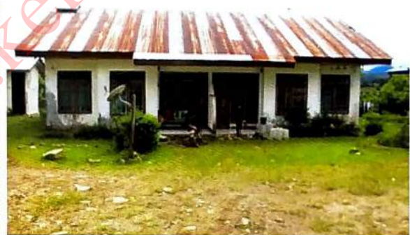
Gedung Mess Para Medis
