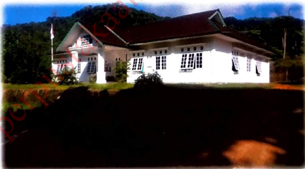
Gambar gedung puskesmas lama (sedang tahap pembangunan gedung baru)
