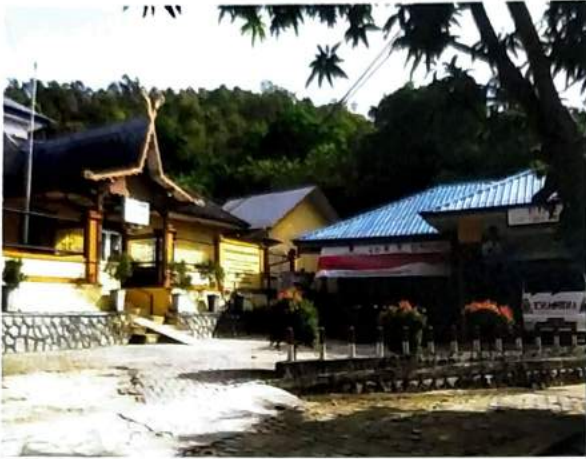
Gedung Puskesmas Tambelan
