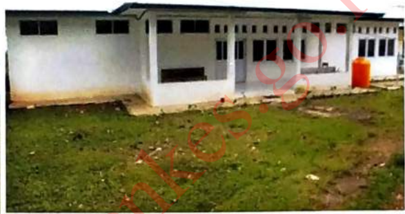
Gedung Rawat Inap
